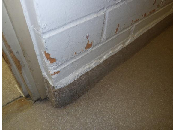
Kuva 6. Väliseinän liittymää tiivistetty (tilan 191 ja 185 välinen)
