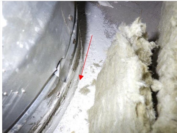
Kuva 24. IV-putkien läpiviennit lattiaan on tiivistetty
