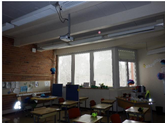
Kuva 16. Yleiskuva luokkatilan ulkoseinästä
