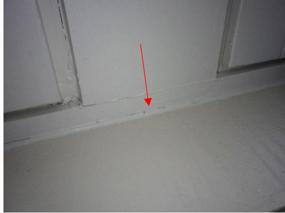
Kuva 27. Ikkunalistoituksessa halkeamia
