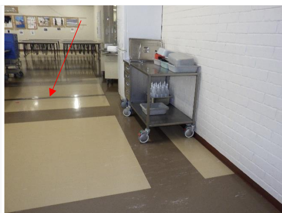
Kuva 11. Lattian liikuntasauma havaittiin tiivistetyksi
