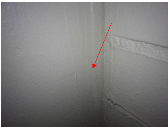
Kuva 30. Pilarin ja ulkoseinän liittymässä on vahvikenauha
