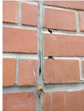
Kuva 18. Elementtisauma epätiivis
