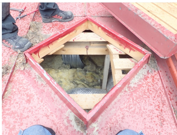
Kuva 27. Matalan osan yläpohjan käyntiluukku
