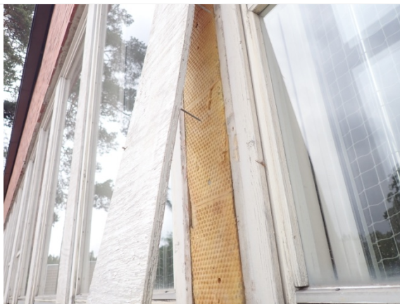
Kuva 15. Ikkunan väli eristetty mineraalivillalla
