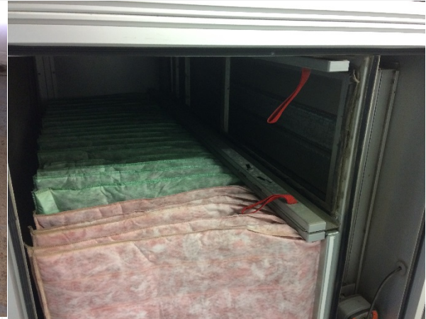
Kuva 32. Suodattimien vaihto kesken, ylärivi tyhjä.
