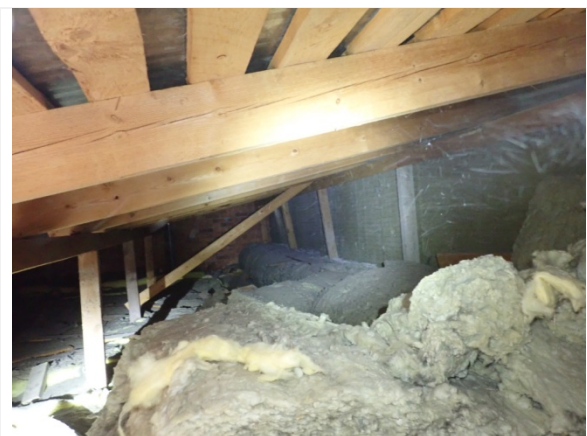
Kuva 28. Matalan osan yläpohja
