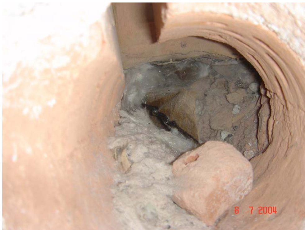
Kuva 11: kellarin seinärakennetta tekstiililuokassa
