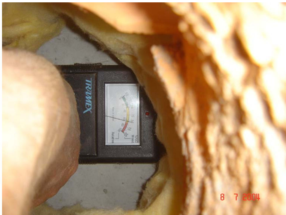
Kuva 3: seinärakenne ruokailutilassa MP 3
