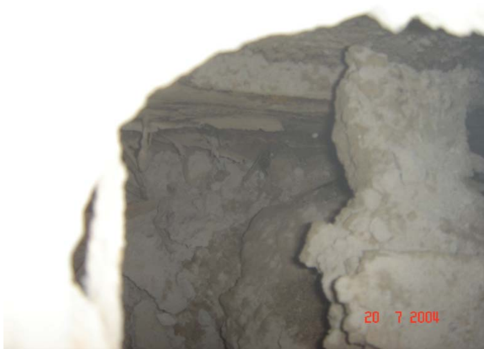
Kuva 9: tekstiililuokan lattiarakennetta betonilaatan alapuolella
