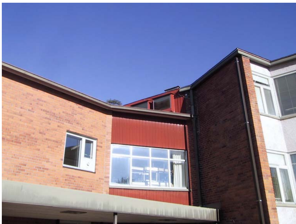
Kuva 14: TK 1 ja -2 säleiköt, luokan 222 ulkoseinää
