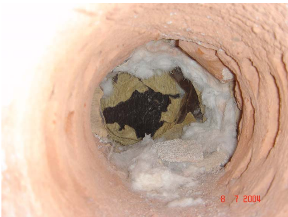
Kuva 10: kellarin seinärakennetta tekstiililuokassa
