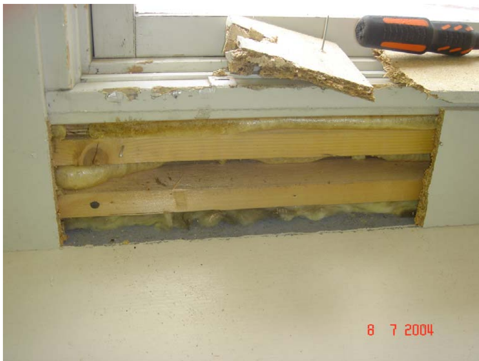
Kuva 12: kotelorakenne tekstiililuokassa ikkunan alapuolella
